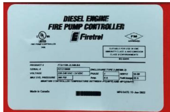
ป้ายชื่อตู้ Controller Fire Pump/Name Plate
