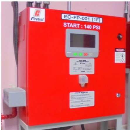
รูปถ่ายตู้ Controller Fire Pump
